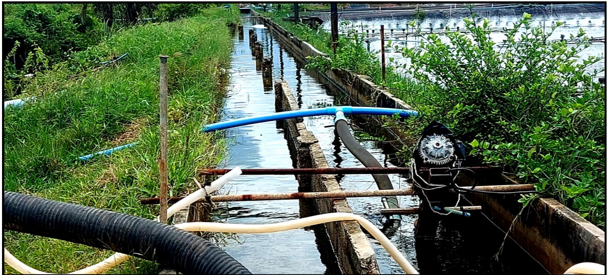
รางซีเมนต์ส่งน้ำเข้าบ่อเลี้ยง
