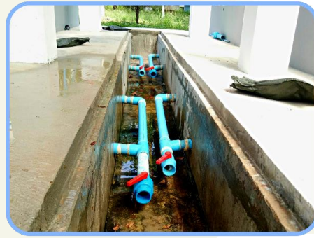
ภาพที่ 47 ลักษณะของบ่อคอนกรีตเลี้ยงปลิงขาว และการเชื่อมต่อบ่อด้วยท่อพีวีซี
