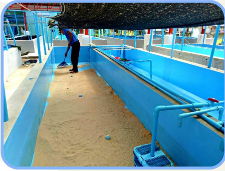
ภาพที่ 47 ลักษณะของบ่อคอนกรีตเลี้ยงปลิงขาว และการเชื่อมต่อบ่อด้วยท่อพีวีซี
