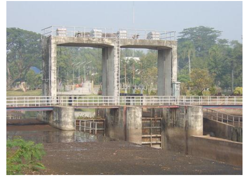
ประตูระบายน้ำ
