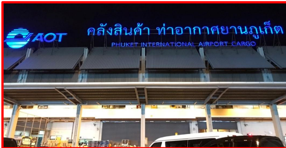
ภาพสถานที่ตั้งด่านตรวจสัตว์น้ำจังหวัดภูเก็ต
