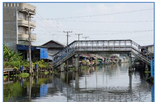
ตึกสมัยใหม่ และสะพานคอนกรีตสำหรับคน เดินข้ามคลองที่สร้างสูงพอให้เรือลอดได้
