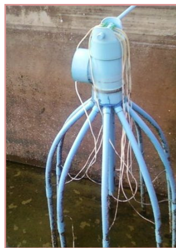
ภาพที่ ๘ เจ้าปลาหมึกยักษ์ ๑๒ ขา มีกำลังหมุนเวียนน้ำมากกว่า ๘ ตันต่อชั่วโมง ที่ทุกระดับความลึก โดยใช้แรงดันอากาศต่ำ
