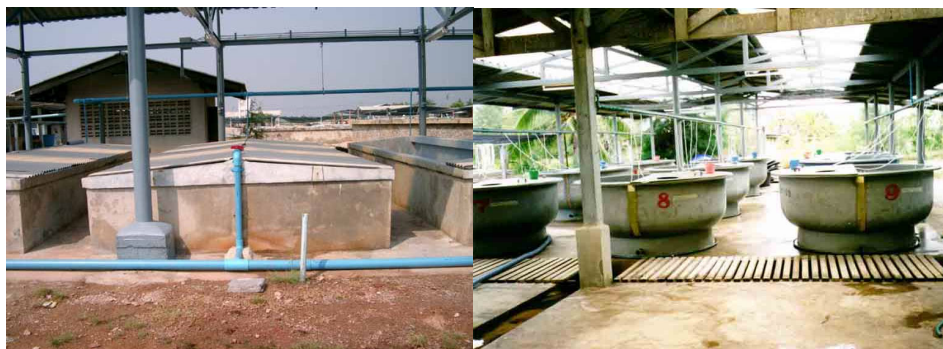
บ่อคอนกรีต
