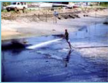
การฉีดเลนทำความสะอาดบ่อ
