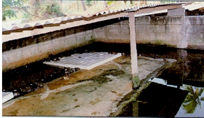
ภาพที่ 10 ลักษณะบ่อและพื้นบ่อ
