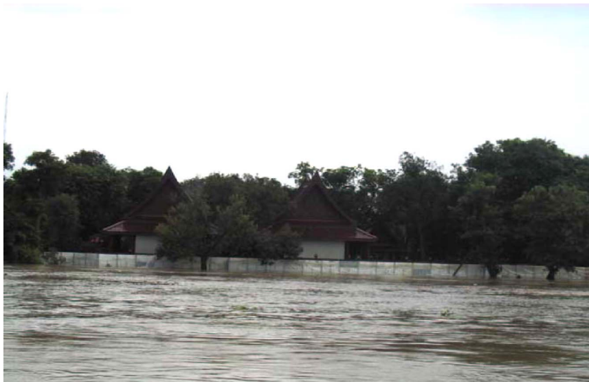
รูปที่ 3-9 คันป้องกันน้ำท่วมกึ่งถาวร แบบแผงเหล็ก ณ พระตำหนักสิริยาลัย จ.อยุธยา (ปี 2549)
