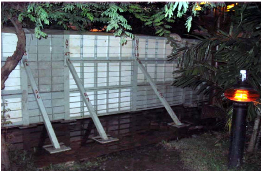
รูปที่ 3-11 คันป้องกันน้ำท่วมกึ่งถาวร แบบแผงเหล็ก ณ พระตำหนักสิริยาลัย จ.อยุธยา (ปี 2549)
