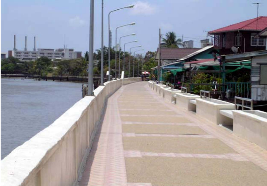
รูปที่ 4-6 คันป้องกันน้ำท่วมแบบถาวร บริเวณเทศบาลเมืองพระประแดง จ.สมุทรปราการ
