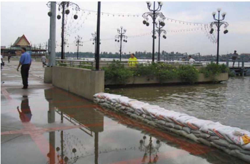
รูปที่ 4-7 การจัดภูมิทัศน์ให้สวยงามและสอดคล้องกับคันป้องกันน้ำท่วม เพื่อประโยชน์การใช้สอยในงานอื่นๆ บริเวณท่าน้ำนนท์หน้าศาลากลางเก่า จ.นนทบุรี (2549)
