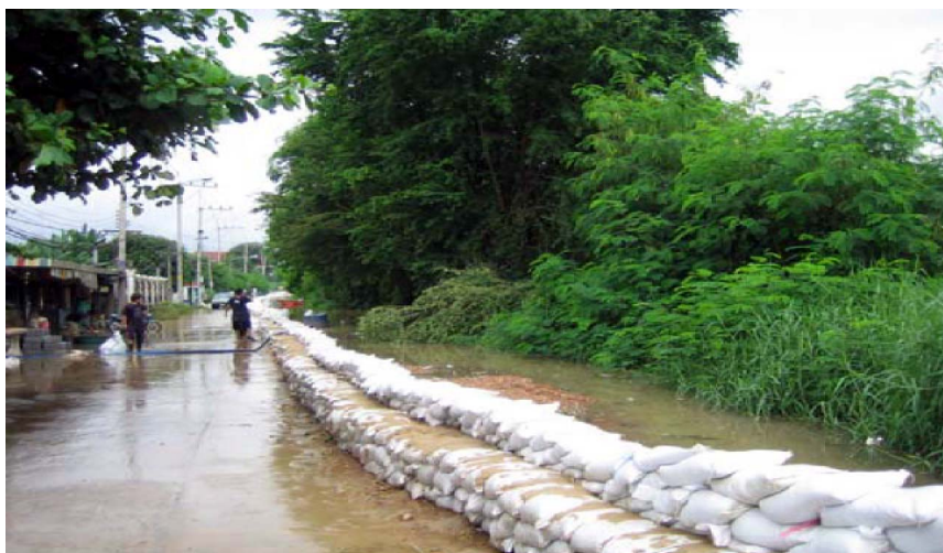
รูปที่ 2-1 รูปแบบคันป้องกันน้ำท่วมชั่วคราวแบบถุงทราย
