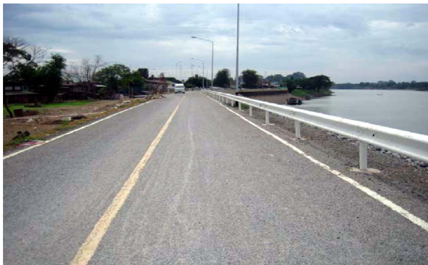
รูปที่ 4-8 คันป้องกันน้ำท่วมแบบคันดิน ที่ชุมชนชัย อำเภอลำทะเมนชัย จังหวัดลำปาง สามารถป้องกันน้ำท่วมได้อย่างสมบูรณ์
