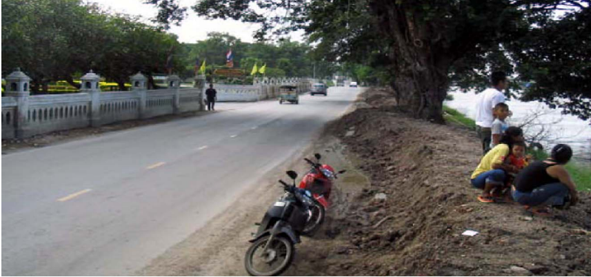
รูปที่ 2-13 คันดินป้องกันน้ำท่วมชั่วคราว ก่อสร้างตามสภาพคดเคี้ยวของตลิ่ง
