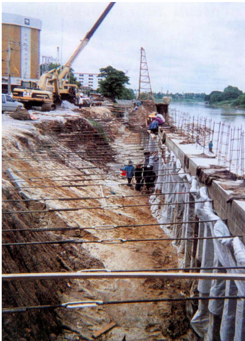
รูปที่ 1-13 สร้างเขื่อนโดยใช้เข็มยาวและมี Stay ตั้ง
