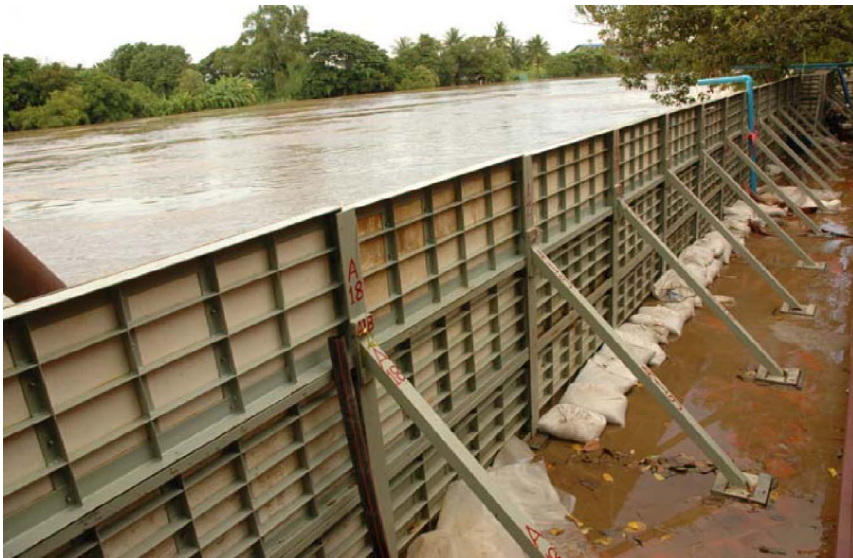
รูปที่ 3-12 คันป้องกันน้ำท่วมกึ่งถาวร แบบแผงเหล็ก ณ พระตำหนักสิริยาลัย จ.อยุธยา (ปี 2549)
