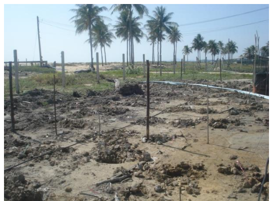
ทำการขุดหลุมตามจุดที่ได้ทำเครื่องหมายไว้
