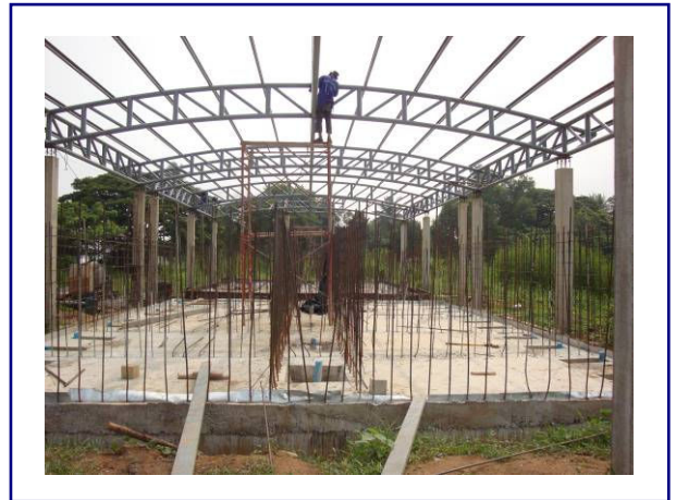
คอนกรีตเต็มพื้นที่ เตรียมเทคอนกรีตผนังบ่อ
