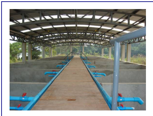
หลังคาเหล็ก และทางเดินบนบ่อกรอง
